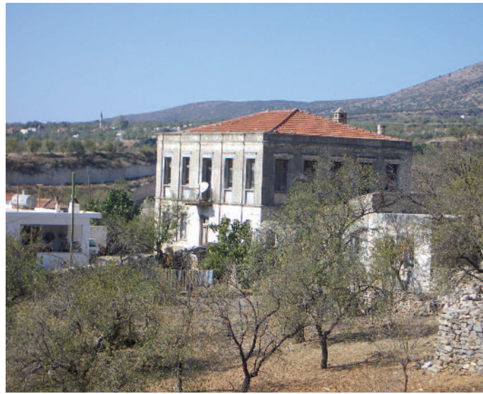
7. Çeşme Mahallesi'nde Ağa Evi Olarak Bilinen Yapı (Rölöve ve Görünüş)
